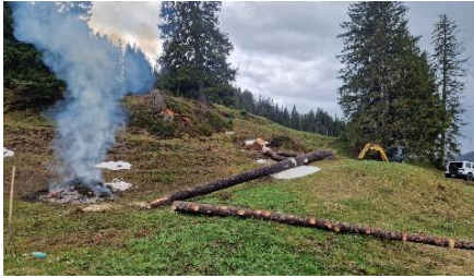
Hausi im Mai auf Chuelibrunnen: Vom Sturm entwurzelte Tannen zerlegen und die Strasse wieder fahrbar machen.
