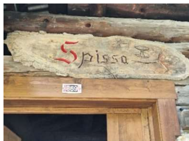
Das Schild über der Eingangstüre wurde sanft restauriert.
