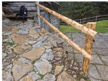
Der verrottete Zaun wurde ersetzt.
